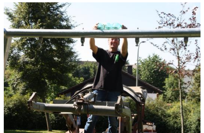
Bild: Wasserwaage Marke Eigenbau; aber keine Sorge, eine richtige Wasserwaage kam zum Einsatz (Foto privat)
