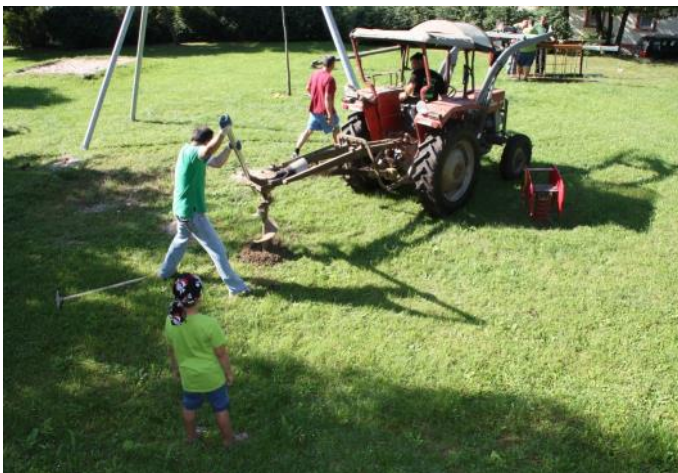
Bild: Löcherbohren mit dem Erdbohrer (Foto privat)
